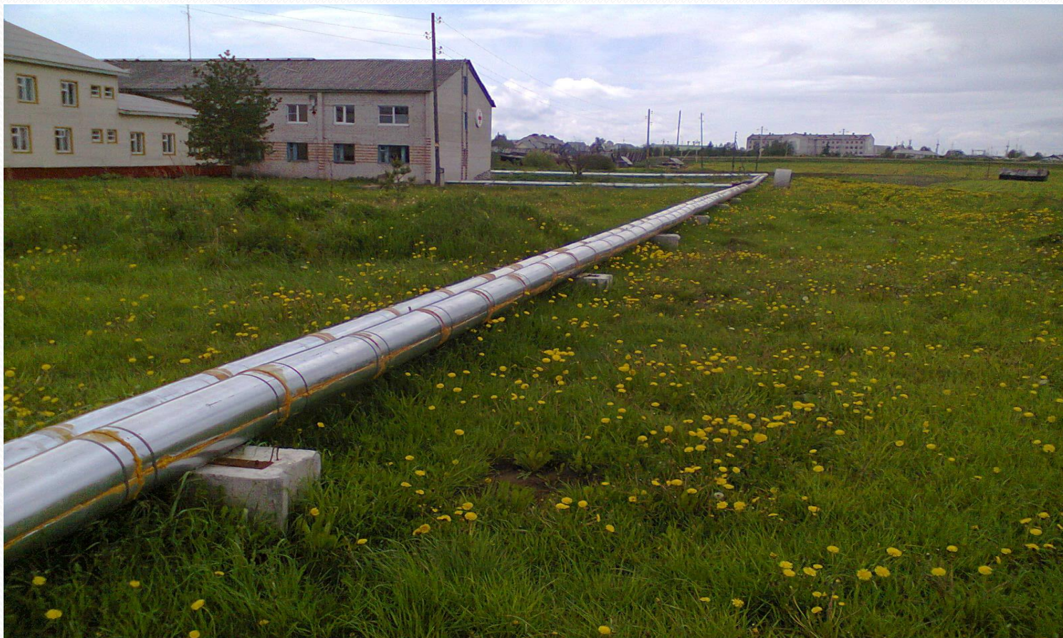
Новая теплотрасса в МО «Емецкое». Стоимость строительства 1 м – 4,2 тыс.руб.
